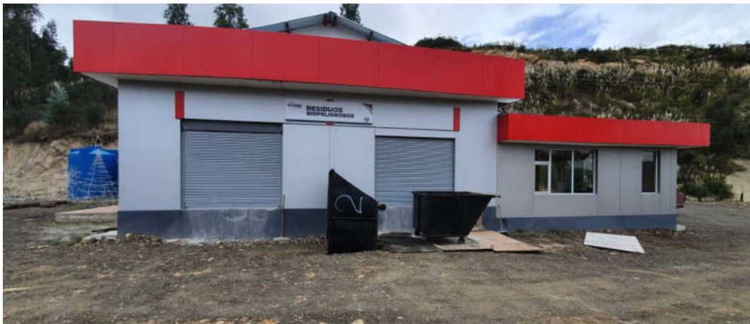
Fotografía 3. Edificación para Residuos Biopeligrosos
