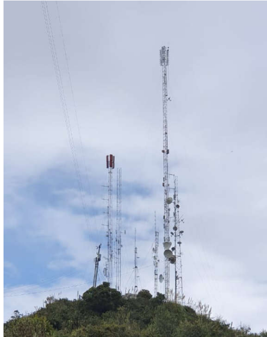
Fotografía 19. Antenas en el Cerro Cojitambo
