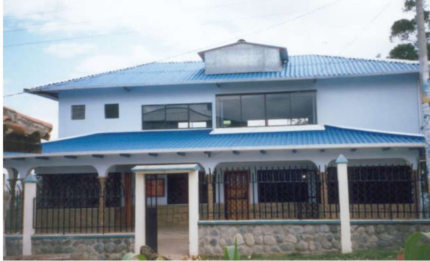
Fotografía 17. Junta Administradora de Agua Potable Regional Cojitambo
