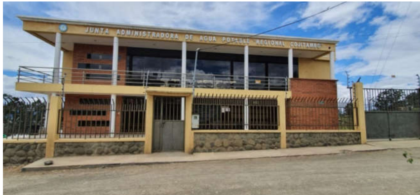
Fotografía 18. Junta administradora de Agua Potable Regional Cojitambo 2019
