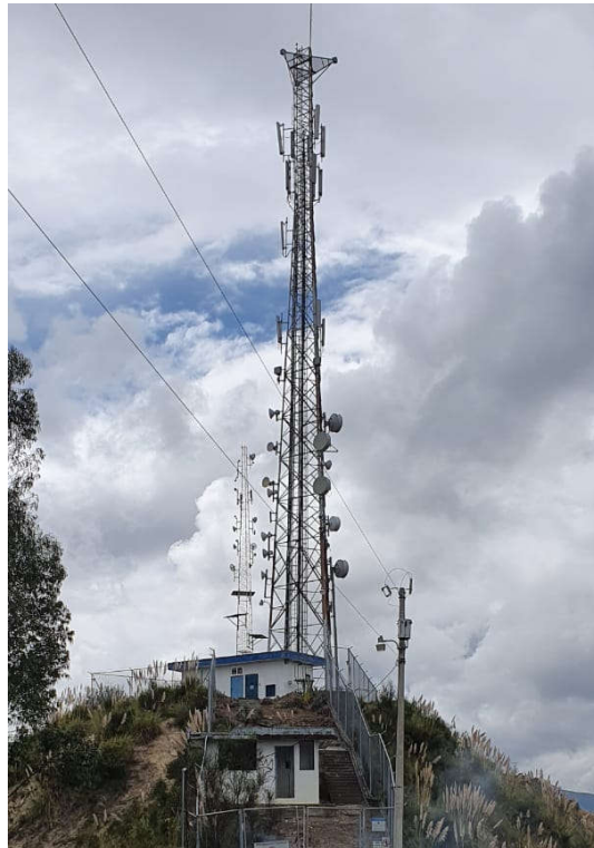
Fotografía 20. Antena Telecomunicaciones Sector Chapte
