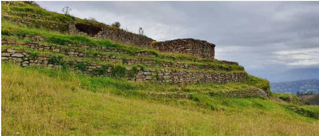
Fotografía 12. Parte de una edificaciones habitacionales - Estado Actual
