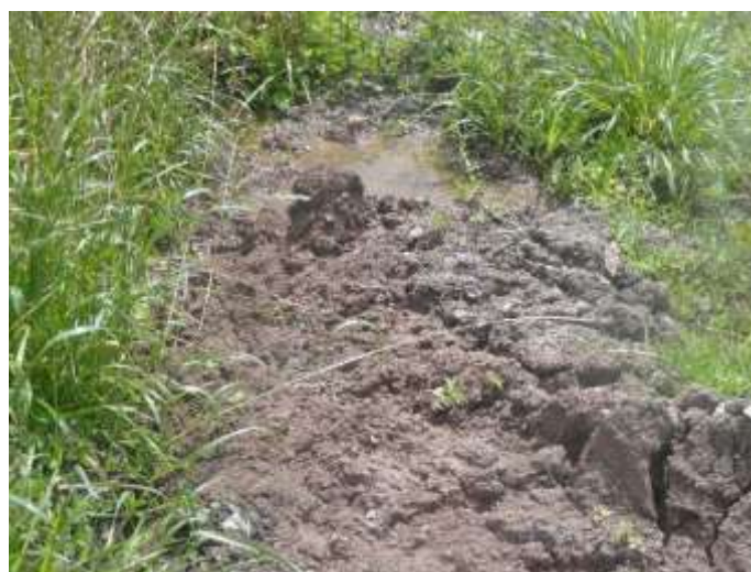
FOTOGRAFÍA NRO. 28: ACUMULACIÓN DE AGUAS DE INFILTRACIÓN EN LA PARTE BAJA DEL DESLIZAMIENTO FUENTE: EQUIPO CONSULTOR
