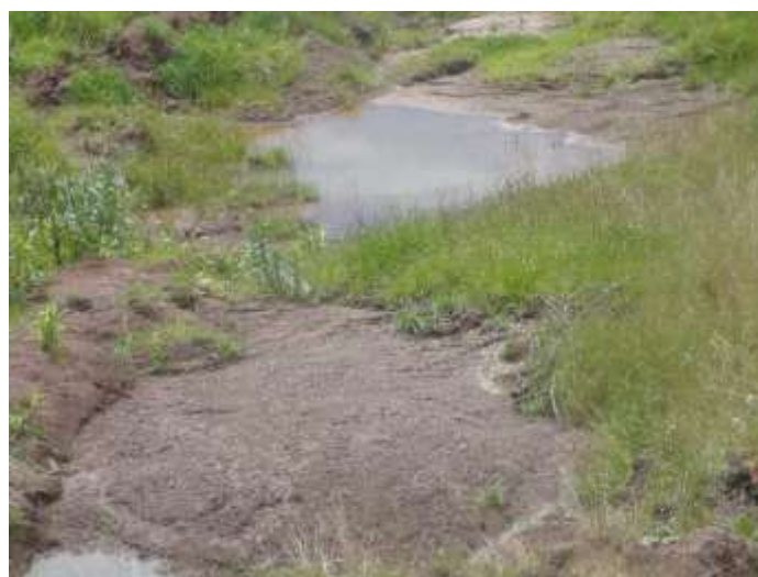
FOTOGRAFÍA NRO. 26: ACUMULACIÓN DE AGUAS DE INFILTRACIÓN EN LA PARTE BAJA DEL DESLIZAMIENTO FUENTE: EQUIPO CONSULTOR
