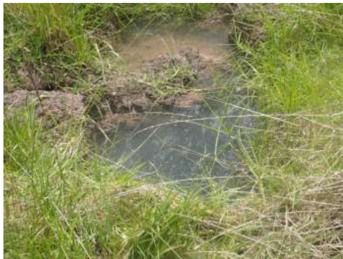
FOTOGRAFÍA NRO. 27: ACUMULACIÓN DE AGUAS DE INFILTRACIÓN EN LA PARTE BAJA DEL DESLIZAMIENTO FUENTE: EQUIPO CONSULTOR
