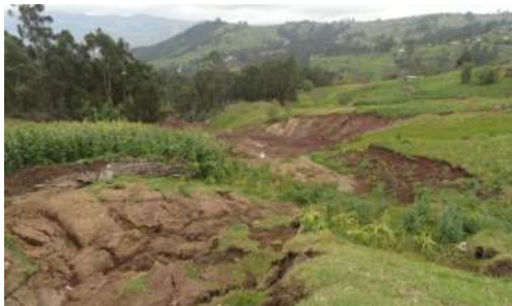
FOTOGRAFÍA NRO. 16: AVANCE DEL DESLIZAMIENTO FUENTE: EQUIPO CONSULTOR ELABORADO POR: EQUIPO CONSULTOR
