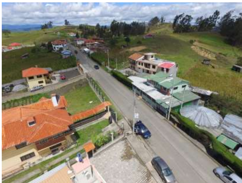
FOTOGRAFÍA NRO. 43: LA VILLA FUENTE: EQUIPO CONSULTOR
