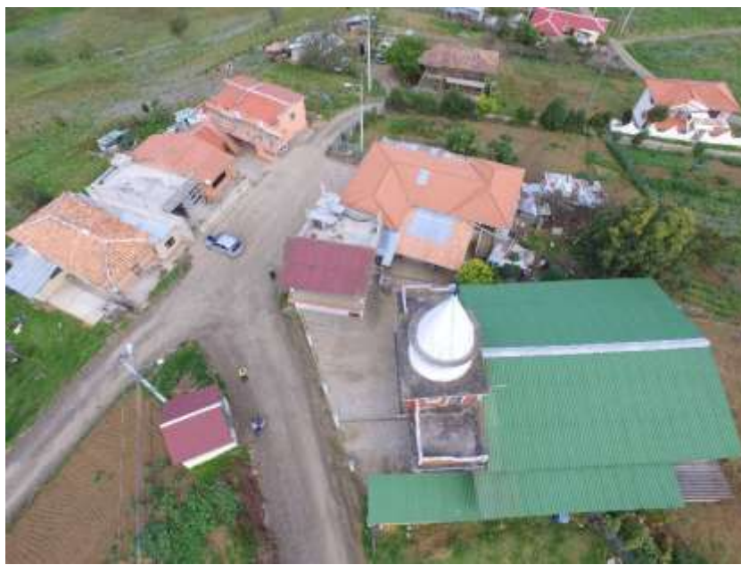
FOTOGRAFÍA NRO. 42: GUABLINCAY FUENTE: EQUIPO CONSULTOR
