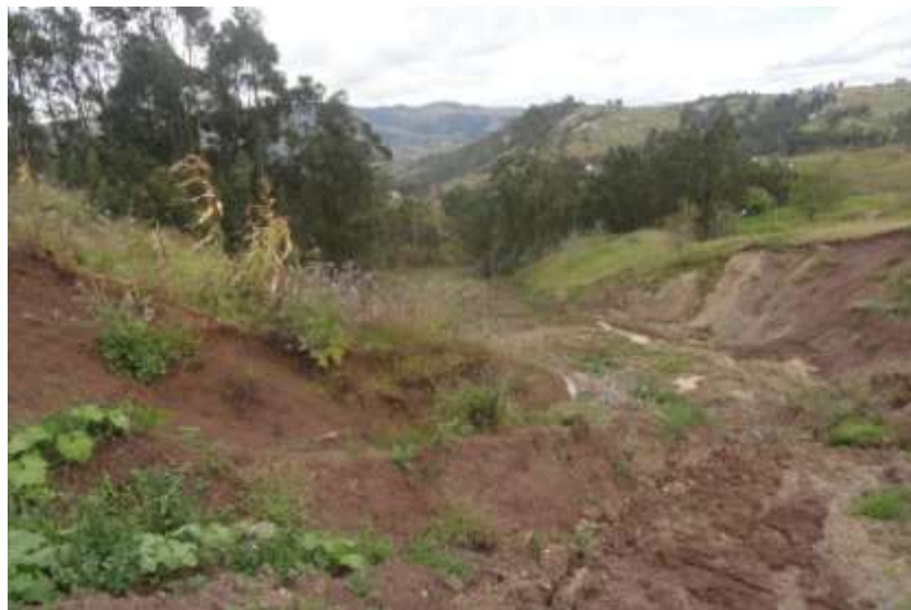
FOTOGRAFÍA NRO. 18: AVANCE DEL DESLIZAMIENTO FUENTE: EQUIPO CONSULTOR ELABORADO POR: EQUIPO CONSULTOR
