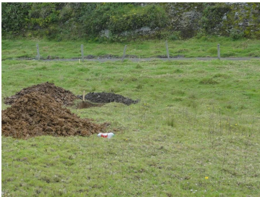
Inicio de las excavaciones en el Parqueadero
