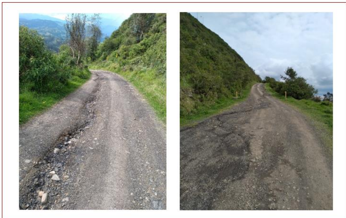
Foto 7. Estado de capa de rodadura de camino en época de lluvias.
