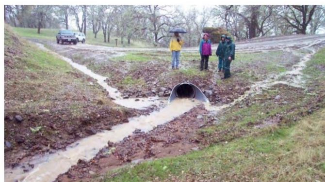
Foto 6 Conectividad de caminos y drenajes
